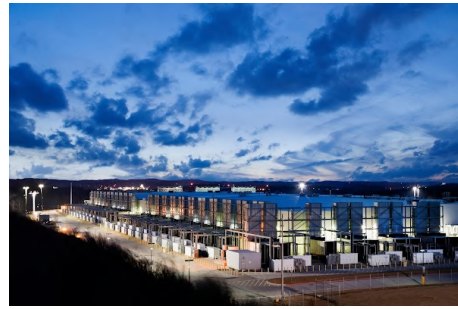
Centro de datos de Google en Georgia (EE. UU.)
